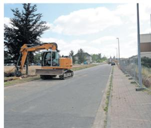
Am Nordrand des Werksgeländes von Meteor schachten Bagger gerade die Gräben zur Verlegung der neuen Wärmeleitungen aus.
